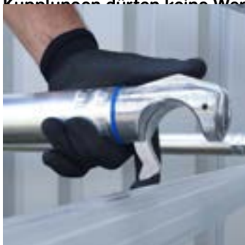
Längsriegel/Diagonale mit Klickverschluss
